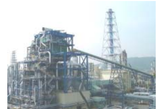
工事が完了した発電設備の外観
