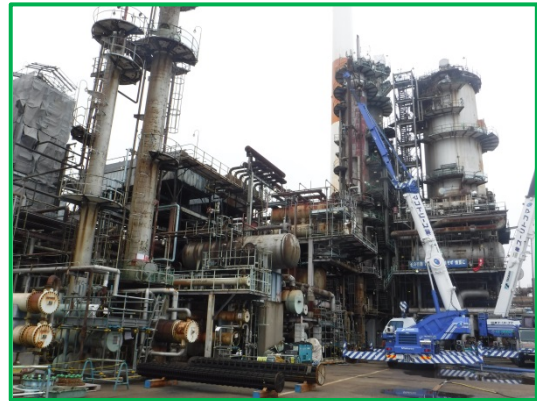
定期修理工事の様子
