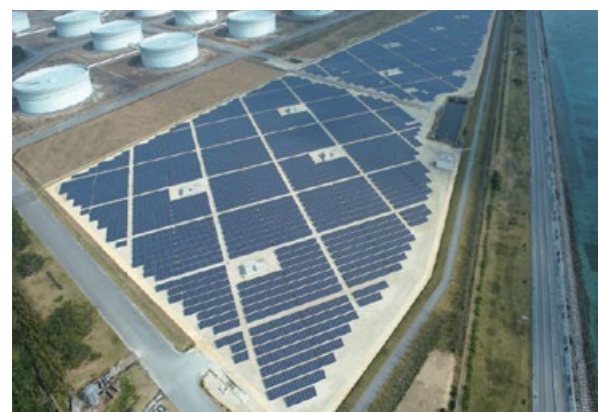
沖縄県最大のウマメガソーラー発電所。年間発電量1,460万kWhは一般家庭約4,000世帯が一年に消費する電力に相当。
