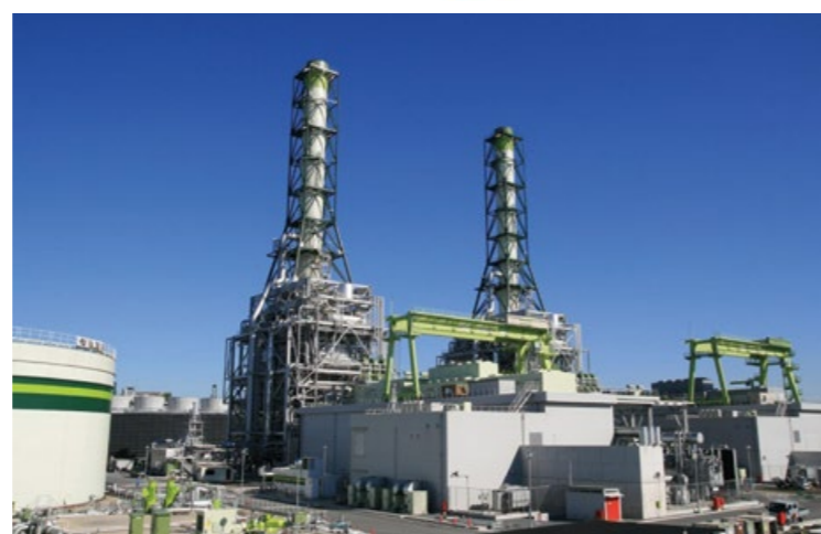
川崎天然ガス発電所
