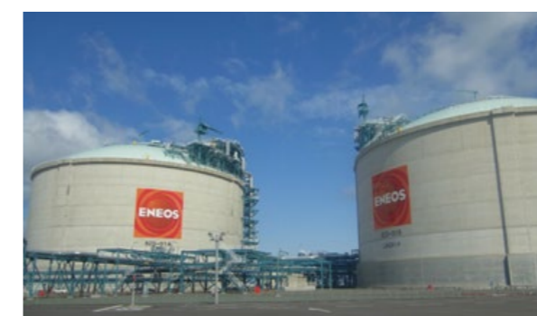
八戸LNGターミナル。LNG貯蔵容量は28万kℓ。
