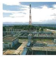
排水処理設備
