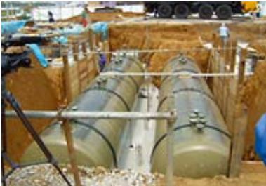
タンク入替工事イメージ
