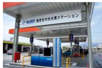
海老名中央水素ステーション
