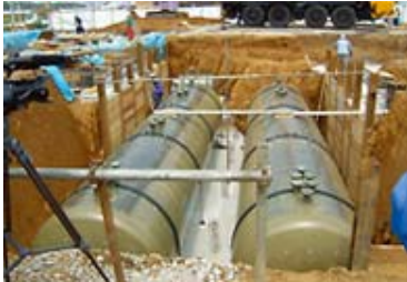
タンク入替工事イメージ
