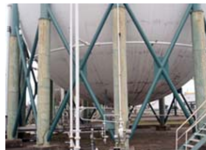
球形タンクのブレース補強例
