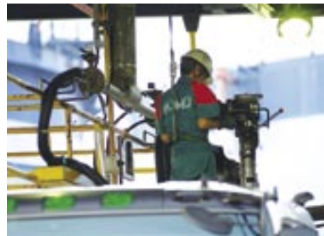
安全帯を使用してのタンクローリーへの充てん作業
