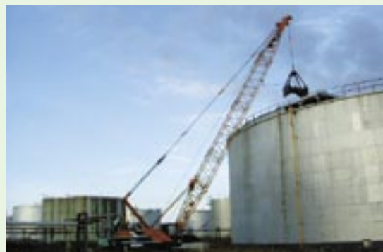
クレーンでの搬出作業
