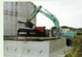
トラックへの積込作業
