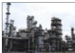
サルファーフリーガソリン製造設備
