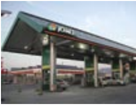
太陽光発電パネル設置JOMOステーション
