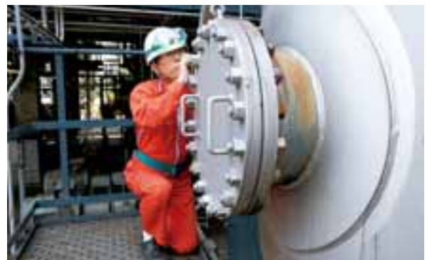
定期修理での検査
