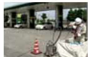
土壌汚染調査
