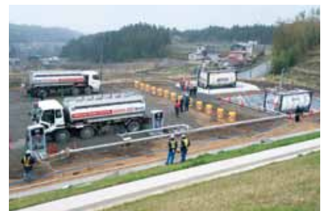
陸前高田市にコンテナ型仮設サービスステーションを設置
