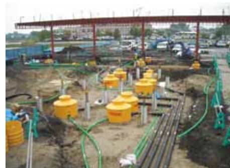
フレキシブル樹脂配管の敷設状況
