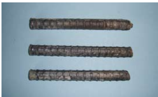
図11 レコサールの暴露試験検体から取り出した鉄筋
