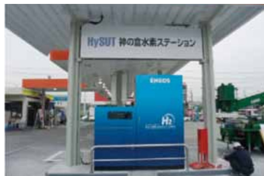
水素充填機（手前）とガソリン計量機（奥）の設置状況
