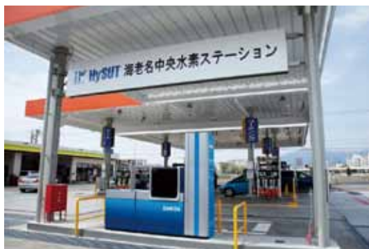
水素充填機（手前）とガソリン計量機（奥）の設置状況
