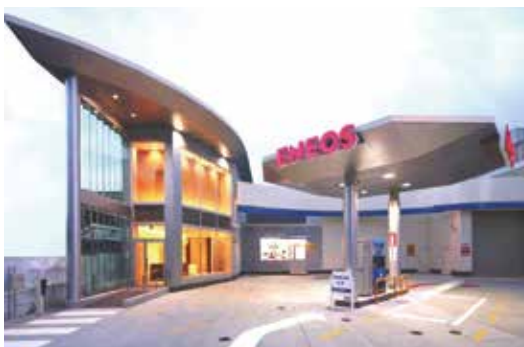
施設外観；ショールーム(左)・ステーション(右)
