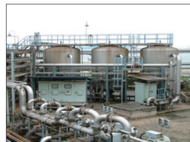
※2 活性炭吸着設備
