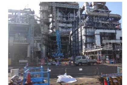
(工事風景 クレーン作業)
