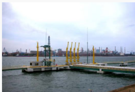
増強工事後の出荷棧橋
