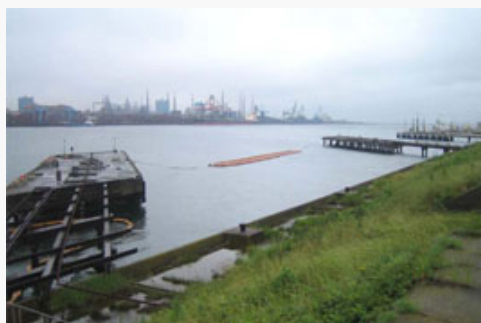
増強工事前の出荷棧橋
