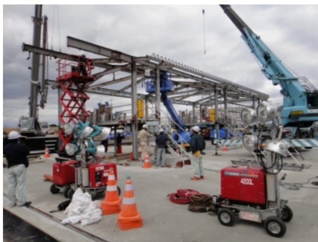
設置中の暫定出荷設備
