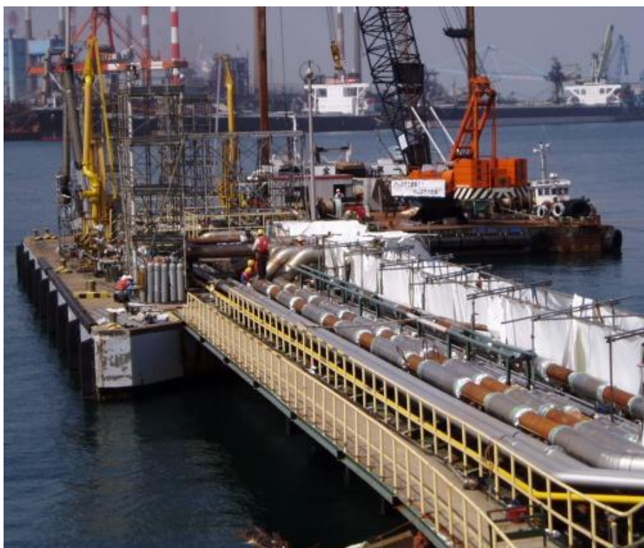
復旧作業中の出荷棧橋
